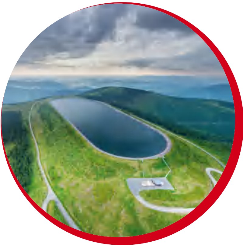
Dlouhé stráně Hydro Power Plant - the largest reversing water turbine in Europe
